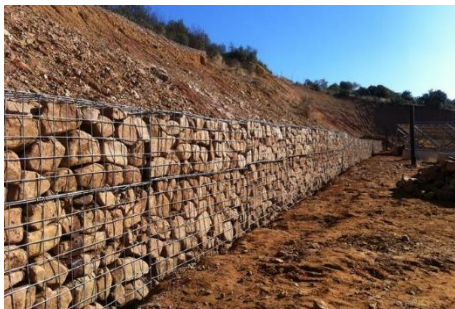
Figura 1: Muro de Contención con gaviones
