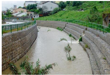
Figura 2: Gavión usado en control de río
