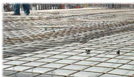
Figura 3: Malla de Ingeniería puesta en obra.
